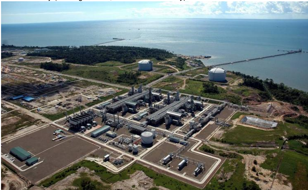
< 液化プラント既存2系列とLNGタンク、栈橋等 > < Plant Facility (existing 2 trains, LNG tanks and Jetty) >
